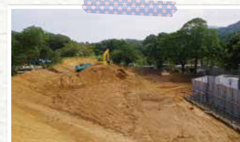
展示場の造成作業の様子(平成26年8月)
