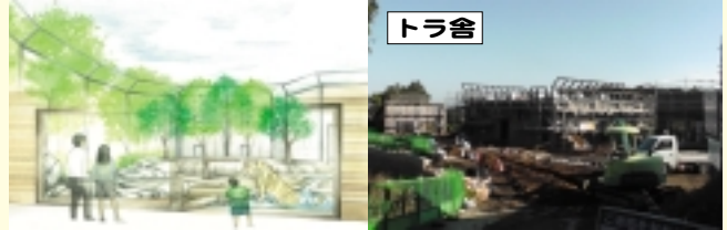
トラ舎とビューイングシェルターの整備を行っています。
